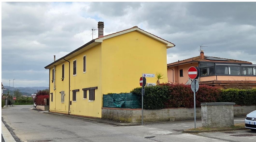
Foto 9: Vista dalla strada dell'edificio residenziale in Via Leonardo da Vinci 16 (US 047013000093277200999): il rilievo di campo ha evidenziato che si tratta di un'unica struttura
