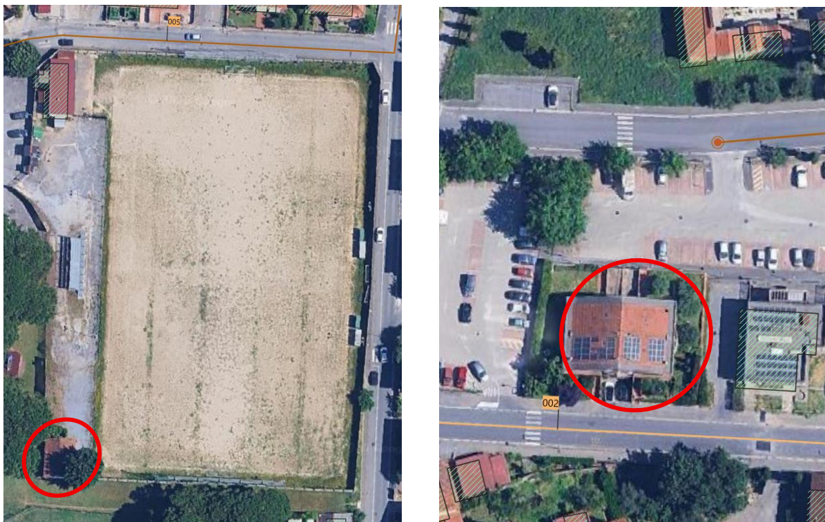
Foto 6: Locale tecnico campo sportivo di Via Ancona (US 047013000000000200999) ed edificio residenziale posto in Via del Poggetto 10 (US 047013000000000100999)
