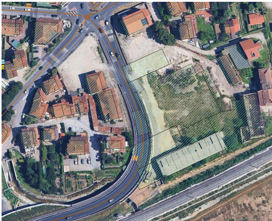
Foto 7: Vecchi edifici ormai demoliti sulla strada di connessione AC 014
