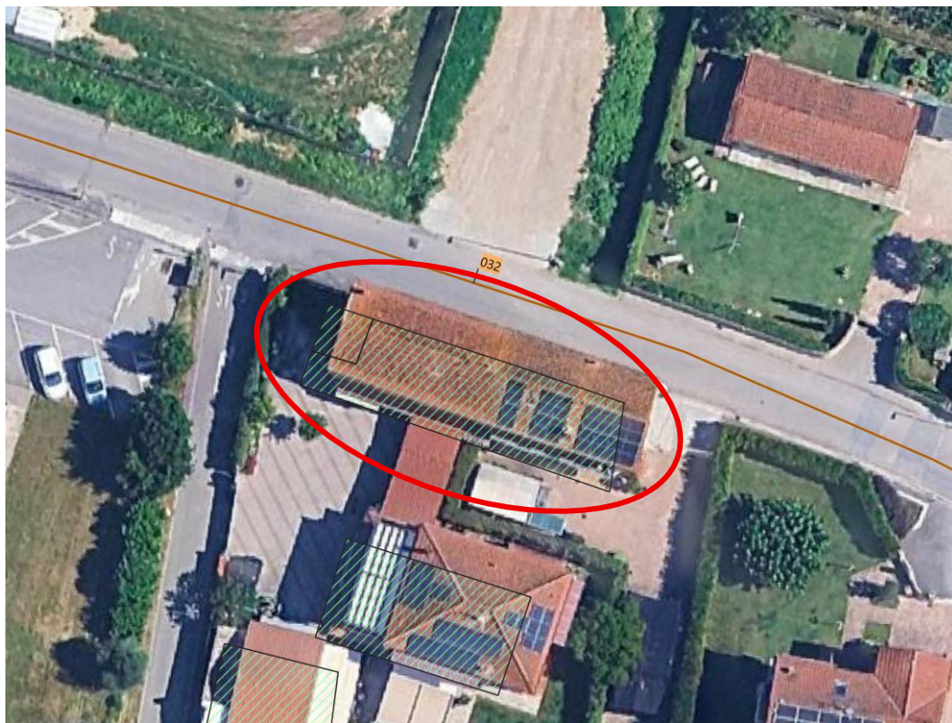
Foto 8: Vista dall'alto dell'edificio residenziale in Via Leonardo da Vinci 16 (US 047013000093277200999)
