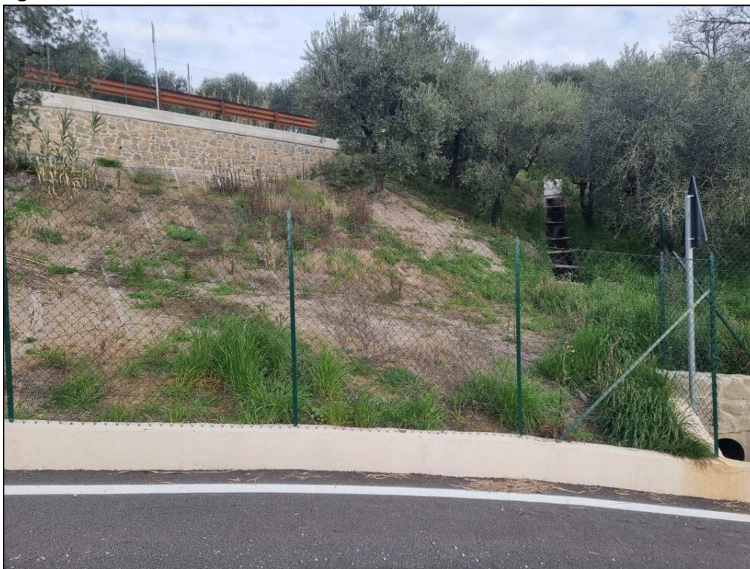
Figura 10. Interventi di bonifica della frana di Via dello Schiavo – marzo 2023.
