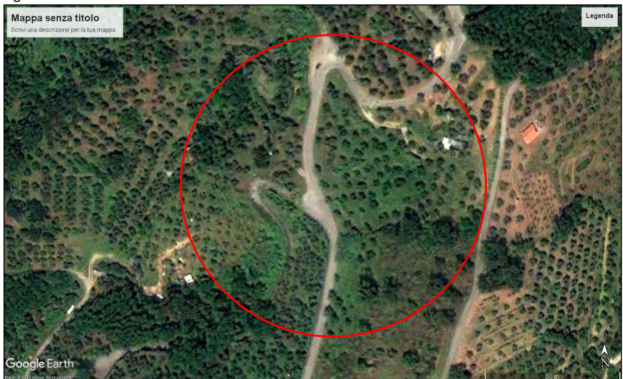
Figura 7. Zona della frana di Via dello Schiavo 2010.
