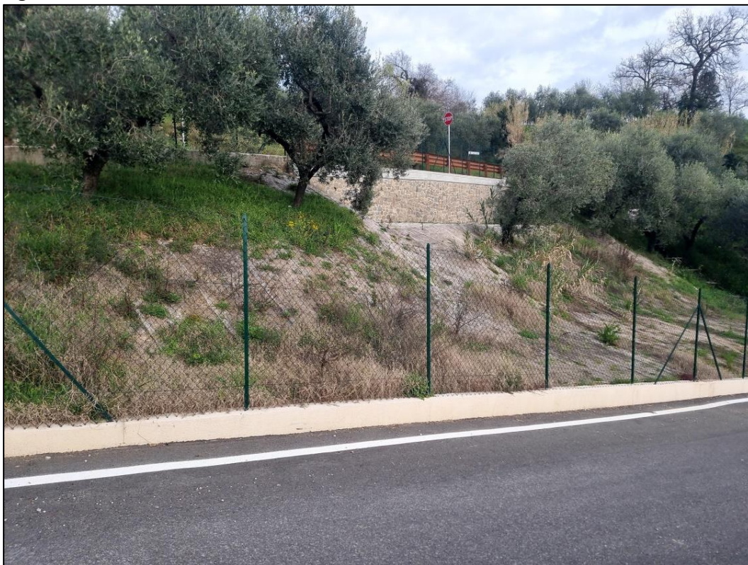
Figura 11. Interventi di bonifica della frana di Via dello Schiavo – marzo 2023.
