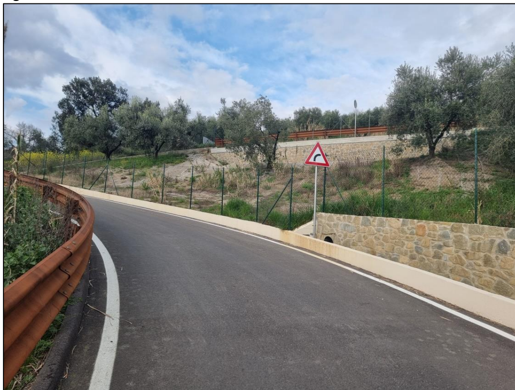
Figura 12. Interventi di bonifica della frana di Via dello Schiavo – marzo 2023.
